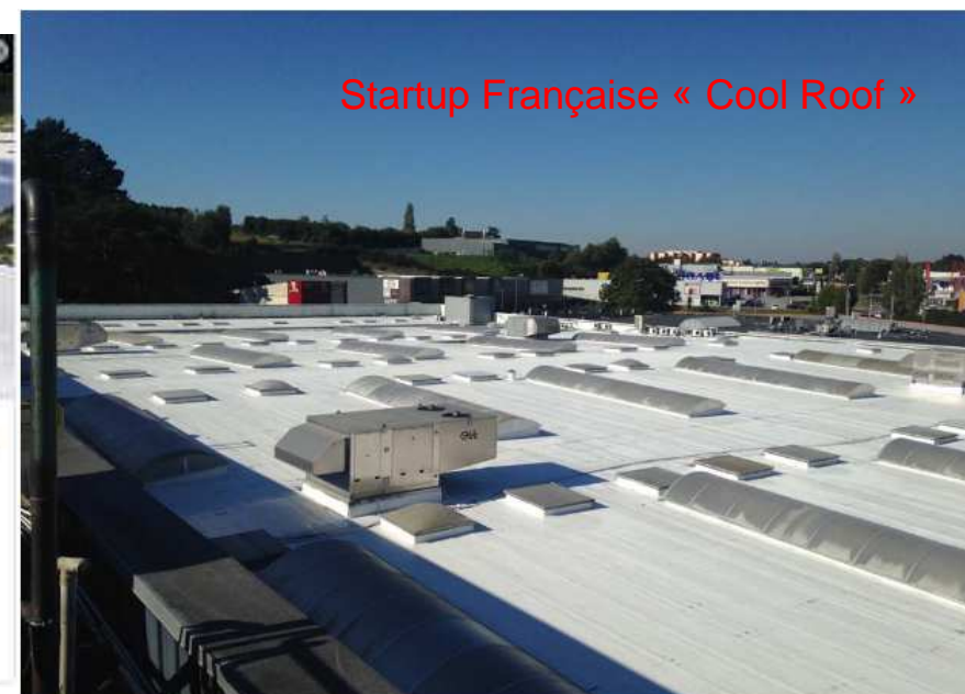
© Cool Roof France Le toit de 7000 m 2 de l'hypermarché Leclerc de Quimper a été revêtu de peinture blanche Cool Roof France
