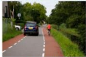
Chaussée à voie centrale banalisée
