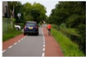
Chaussée à voie centrale banalisée
